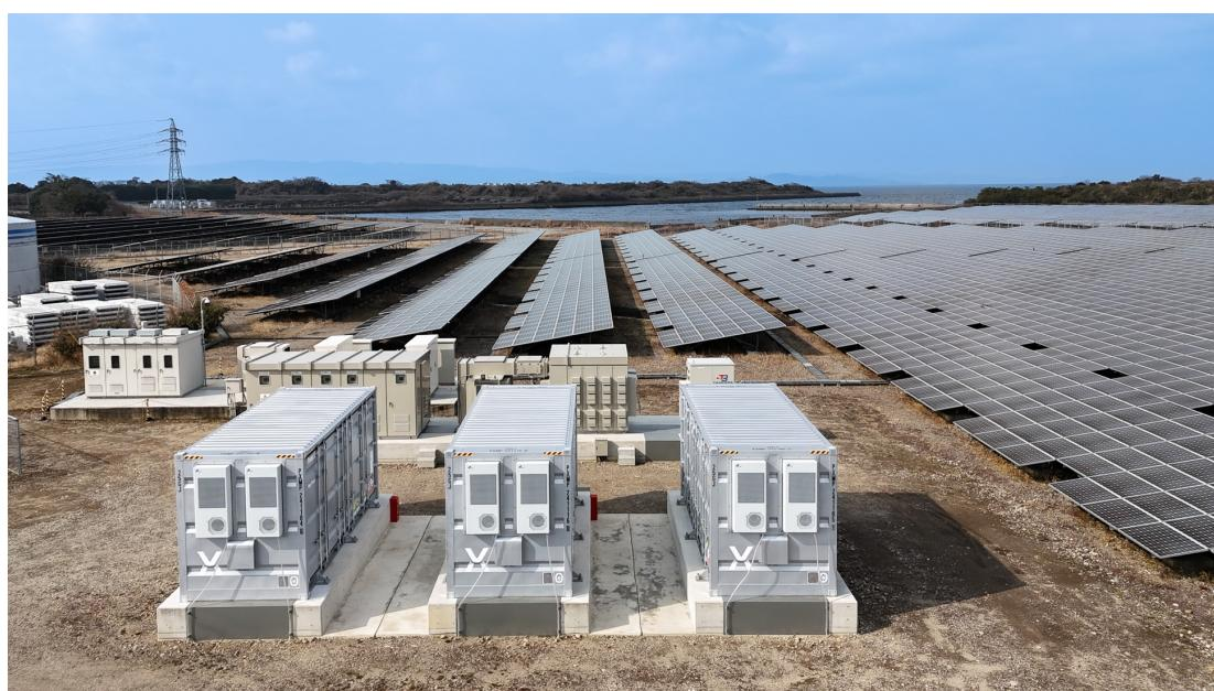
本システムは、パワーエックスの蓄電システム「Mega Power 2700A」と、ニシム電子工業のエネルギー・マネジメントシステム「TAMERBA EMS」で構成されます。昼間は太陽光発電所から蓄電池に充電して出力制御を回避し、夕方は放電して売電するタイムシフトで、再生可能エネルギーの有効活用と価値向上を実現します。さらに、国内の太陽光併設型蓄電池としては初めて、需給調整市場の一次調整力にも対応しています。タイムシフトと調整力を組み合わせたマルチユース運用により、収益の最大化を図ります。
